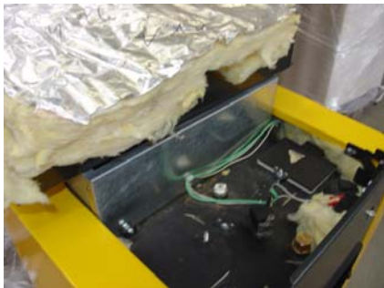
Bild 12: Deckel und Isolierung entfernen
