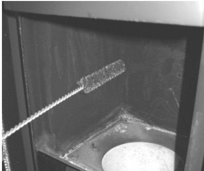
Bild 11: Feuerraum reinigen
