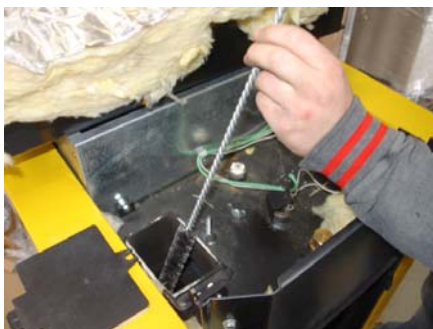
Bild 13: Wärmetauscherflächen reinigen
